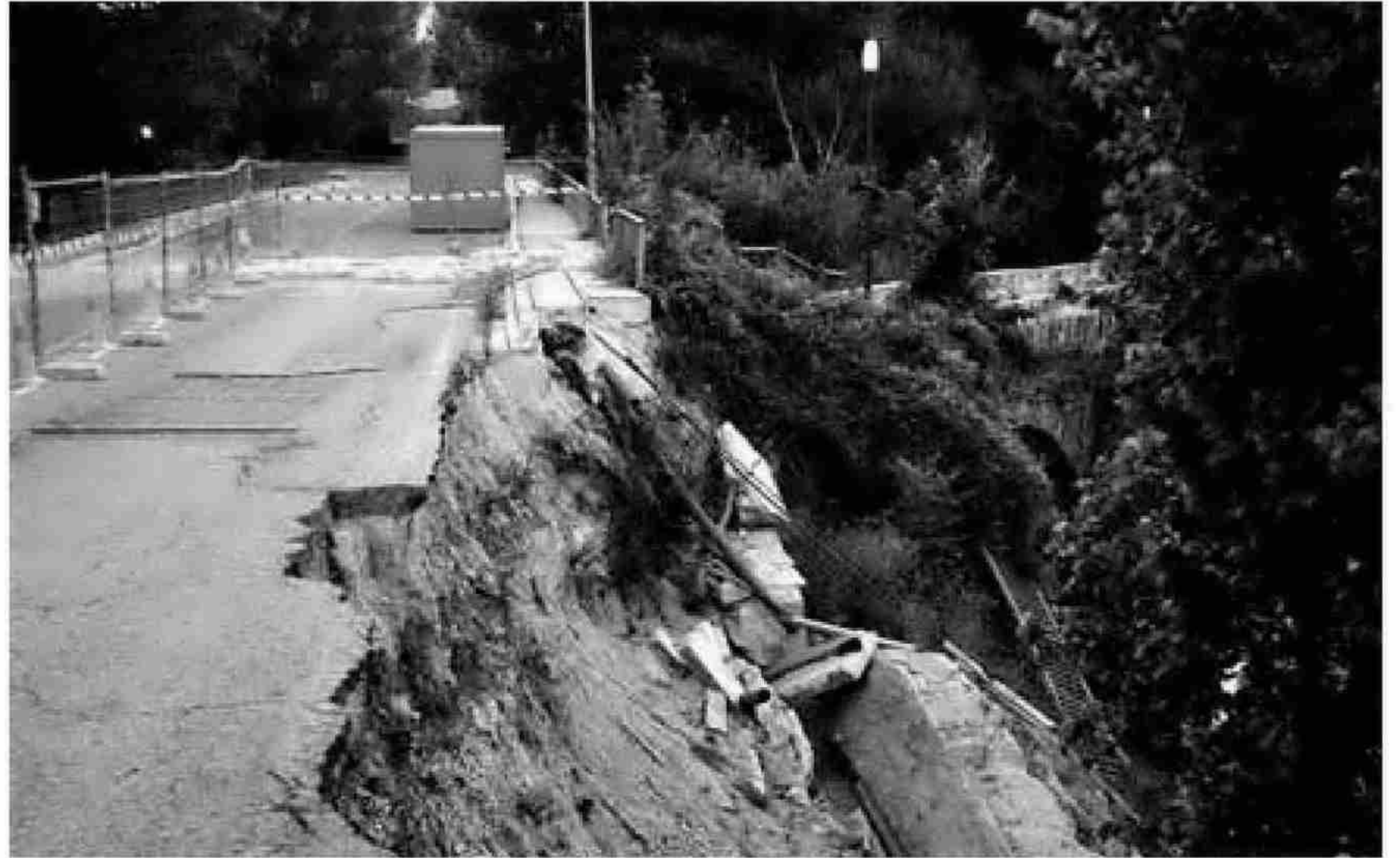
El puente de Areta, en Huarte, ayer con la caseta de obra al fondo. FOTO: JAVIER BERGASA
